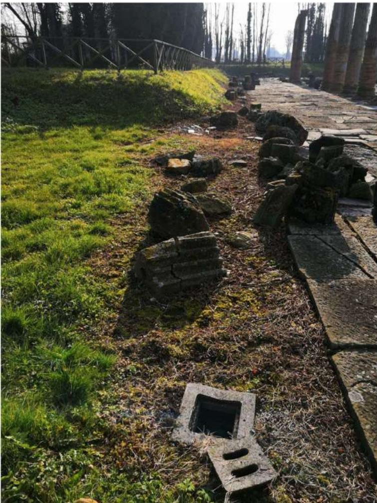
Nell'immagine è visibile il pozzetto già esistente a cui ci andremo a raccordare per poi immettersi nella rete esistente.
