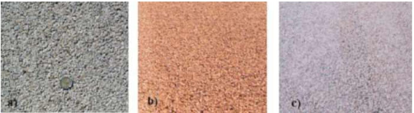
Figura 3 - Aspetto estetico della pavimentazione: a) Usura con legante chiaro e aggregati calcarei; b) Depolverizzazione con aggregati rossi; c) Trattamento superficiale monostrato con aggregati calcarei [Grilli, 2015]
