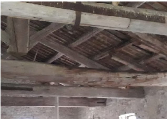
Figura 2 Degrado capriate in legno della copertura
