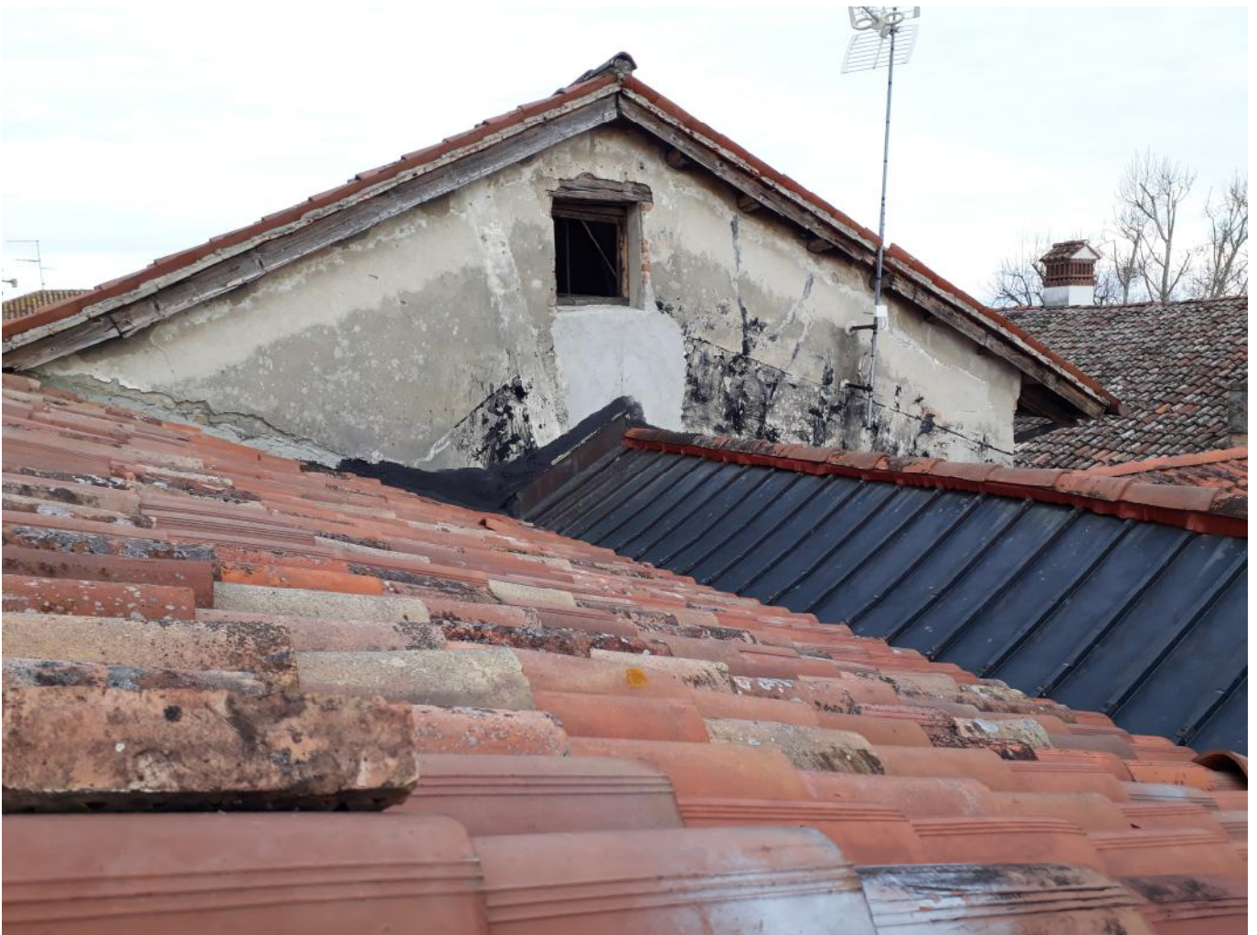
Figura 10 Vista dell'intersezione tra le coperture in corrispondenza del vano scale principale.
