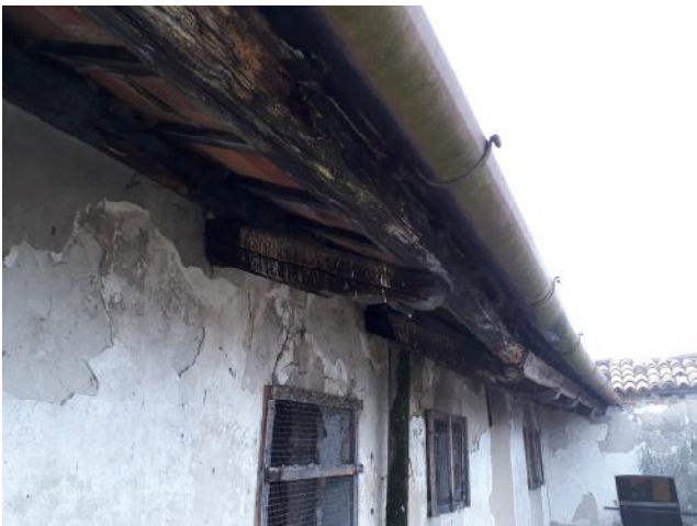
Figura 3 Degrado della linda lato corte interna
