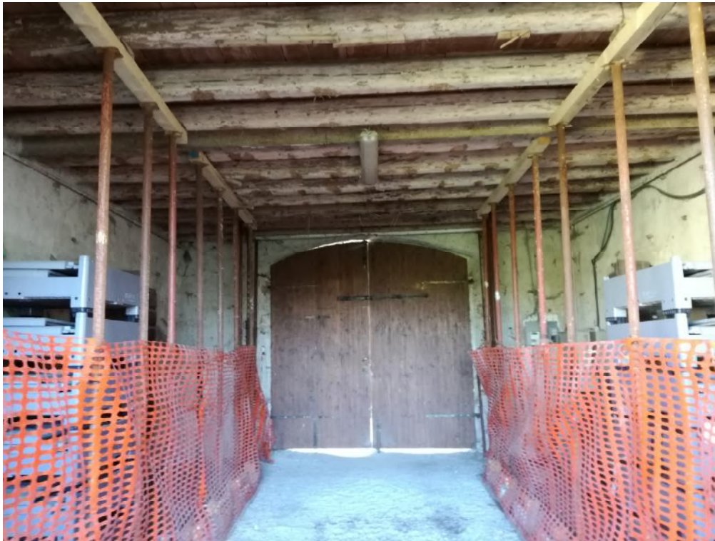
Figura 6 Consolidamento solaio portico d'ingresso;
