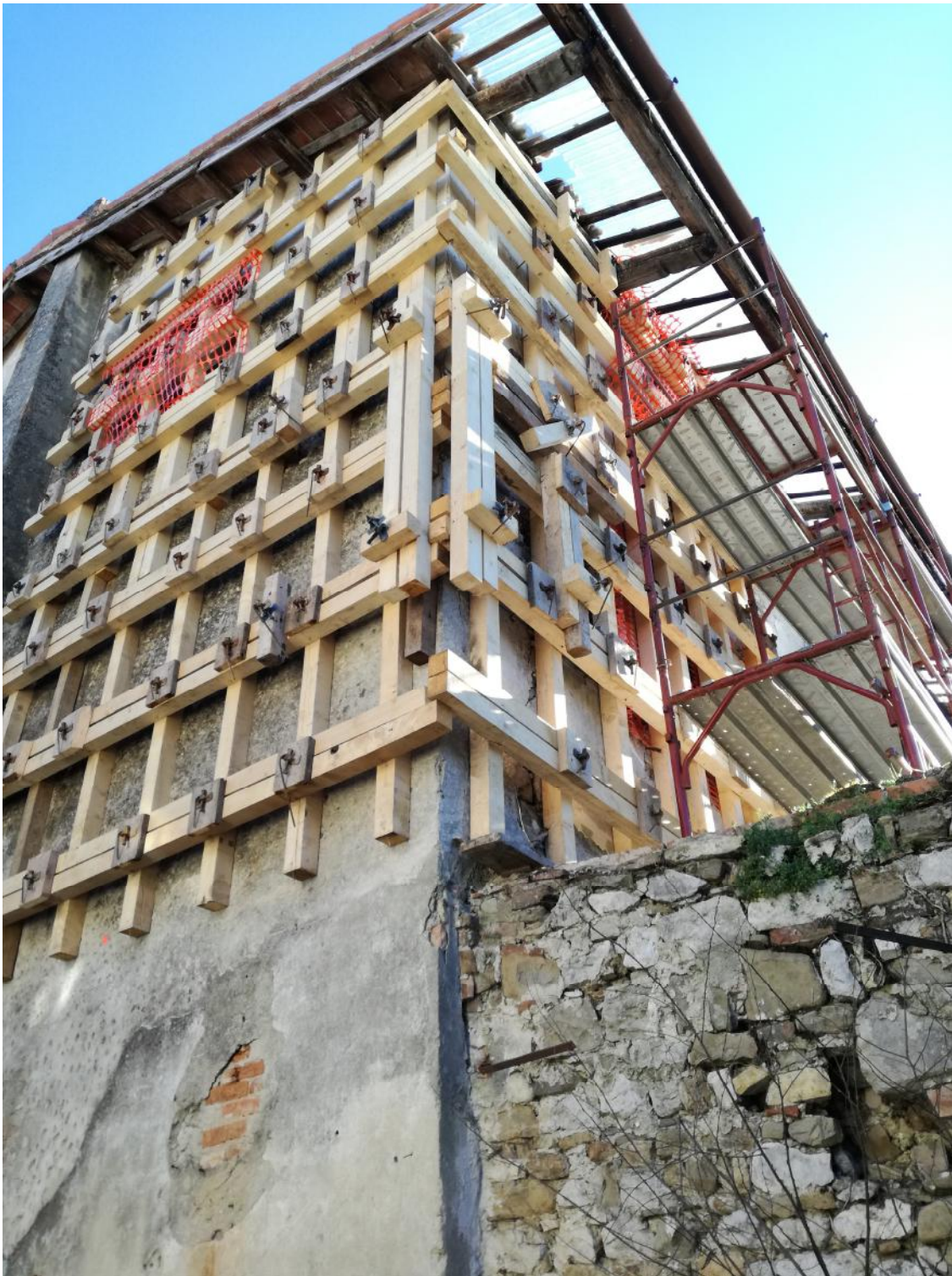
Figura 7 Consolidamento angolo NORDEST e alleggerimento linde
