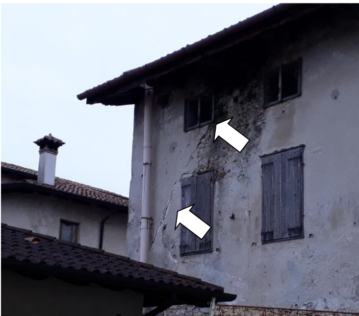
Figura 5 Cedimento dell'angolo nord
