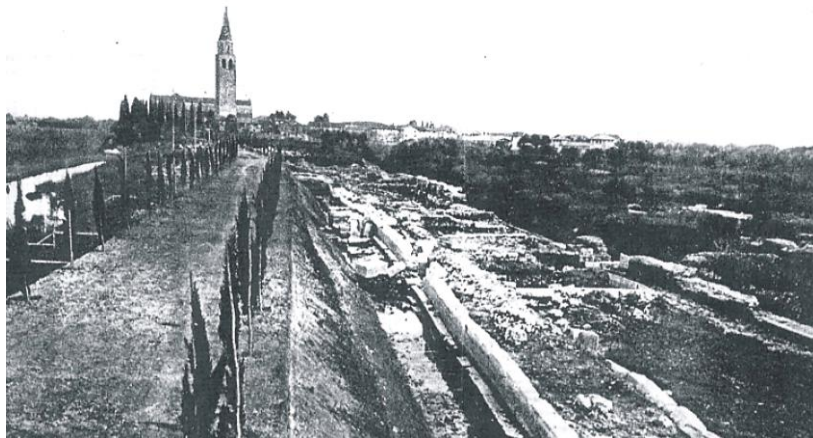
Realizzazione della Via Sacra
